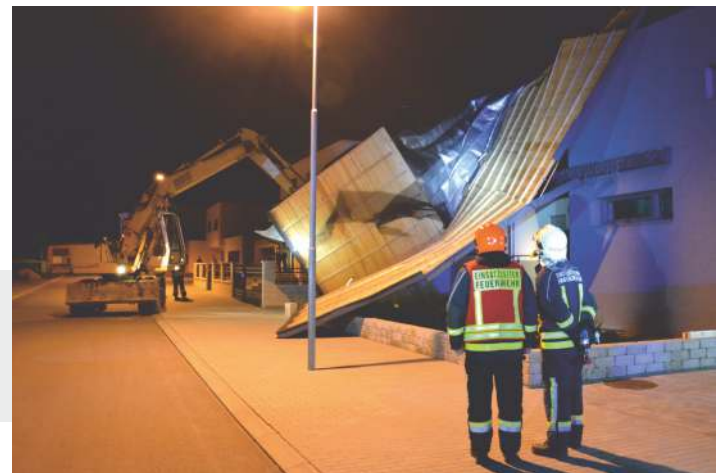
12.12.2017 Technischer Einsatz nach Sturm, der ein ganzes Dach abdeckte
